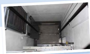
Z výstavby nového výťahu hradenej z prostriedkov OPZ
