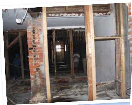
Podkrovie polikliniky v havarijnom stave pred realizáciou projektu
